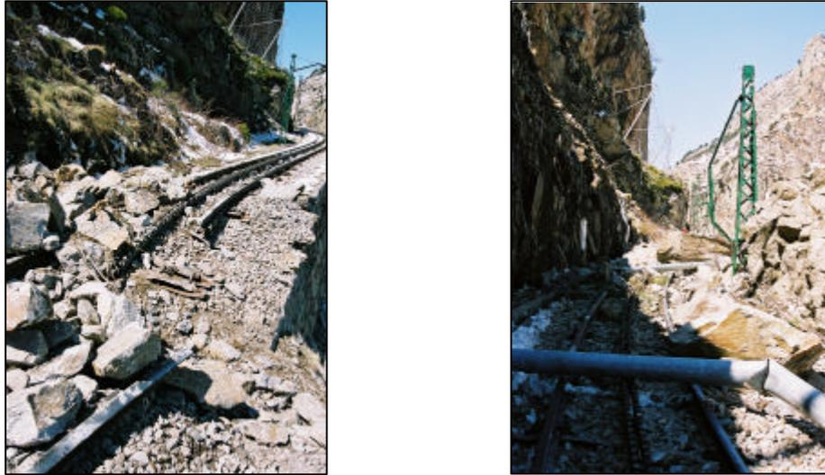
Figura 3: Desperfectos sobre la vía originados por los desprendimientos del 4 de Abril del 2003.
